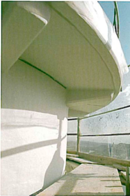
Sanierter Kamin im Endzustand
